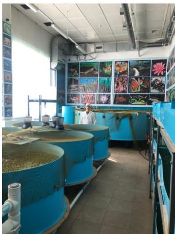
**Рисунок 1 – Установка замкнутого водоснабжения научно-образовательного центра ФГБОУ ВО РГАТУ**
